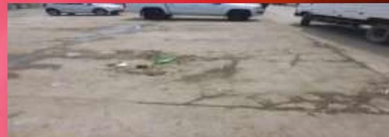
**Pavimento rígido a demoler, con fisuras varias en la zona de estacionamiento vehicular, próxima al Terminal Pesquero**
