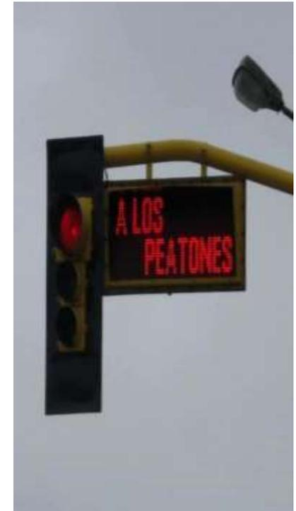
Paneles electrónicos que accionan con la luz roja del semáforo emitiendo mensajes alusivos a seguridad vial y respeto a las normas de tránsito. 09 telemáforos instalados en las principales vías de acceso al Callao y 01 en las instalaciones del Centro de Control de la MPC.
