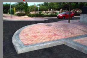
Acondicionamientos de todos los martillos a lo largo de la Avenida
