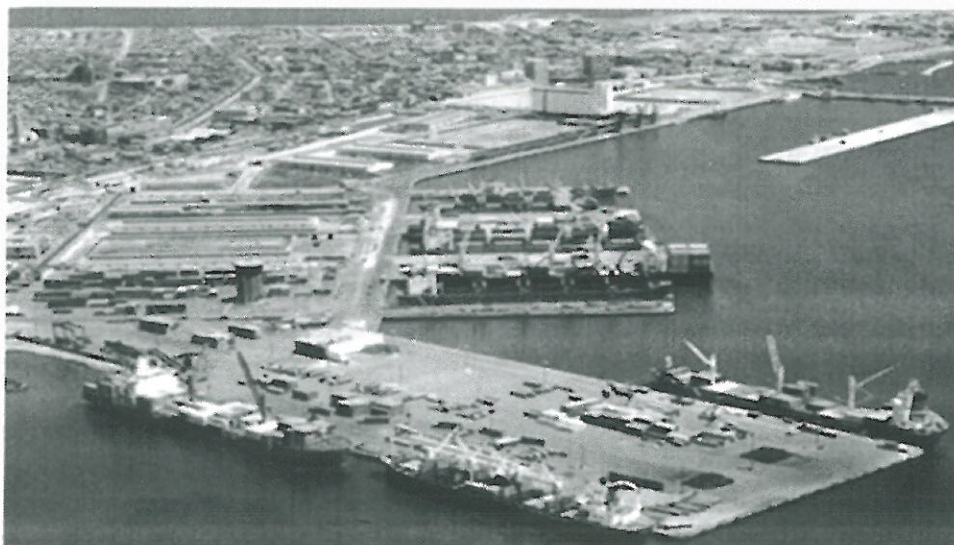
Foto N°7.5.1: Vista del Puerto del Callao
