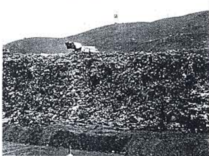
Imagen N° 14. Tractor de oruga esparciendo y compactando RSU. Nótese la altura del relleno de unos 10m.
