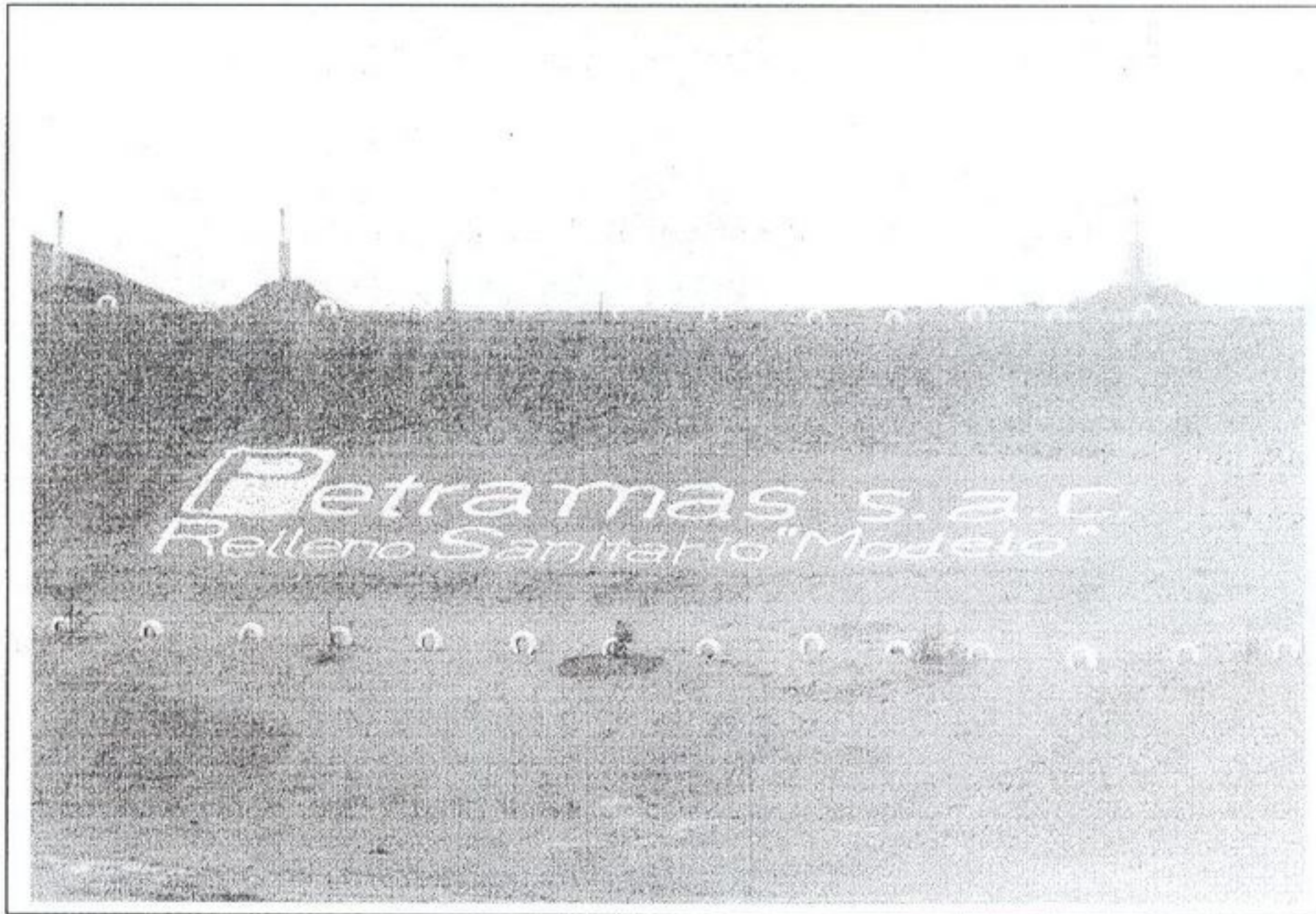
Figura 35: Otra vista que nos muestra el ingreso a la planta de PETRAMAS SAC
