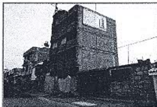
Foto N° 02: Construcción de viviendas
