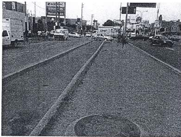
Vista de la Berma lateral de la AV. Oscar R. Benavides sentido lado Sur
